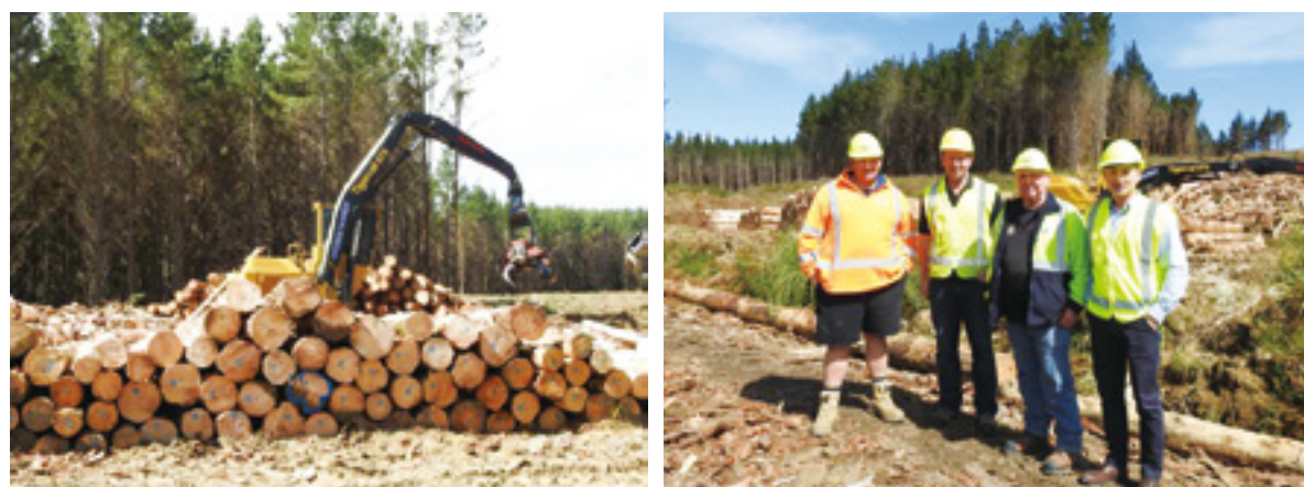
修建基础设施现场
